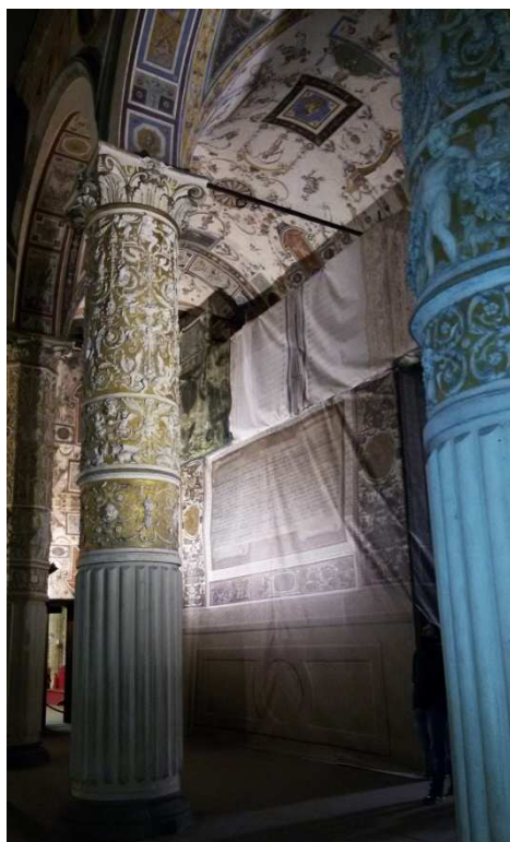
Pohľad na prebiehajúce práce
